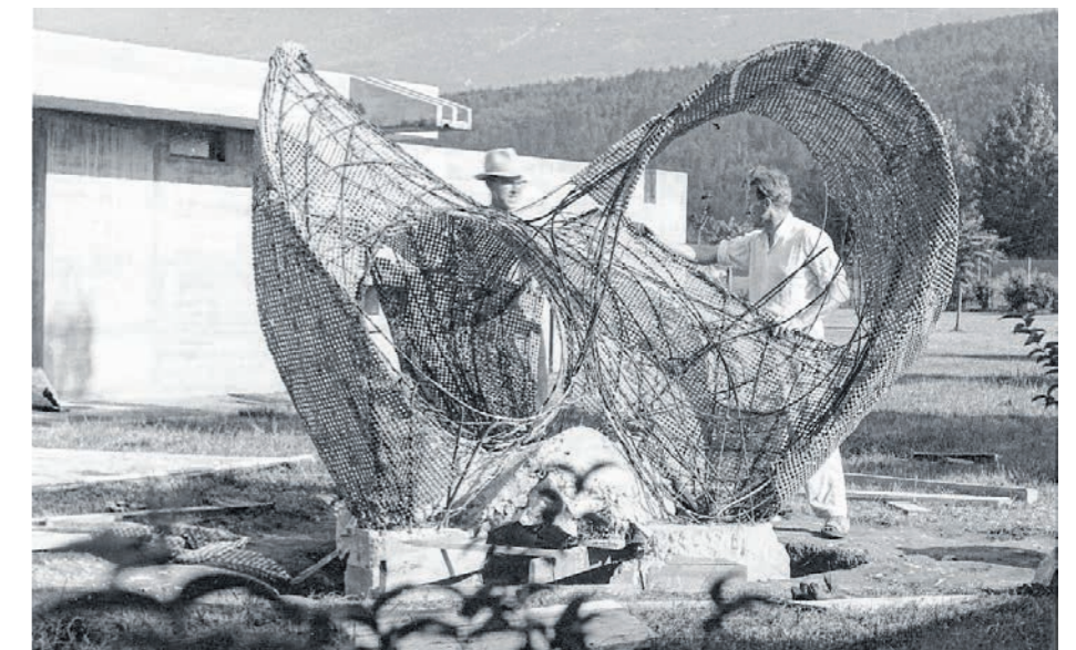
Abb. 5: Aufbau. Das Foto zeigt die Entstehung der von Peter Schneider 1960/61 gestalteten abstrakten, wellenförmigen Beton-Spielplastik.
