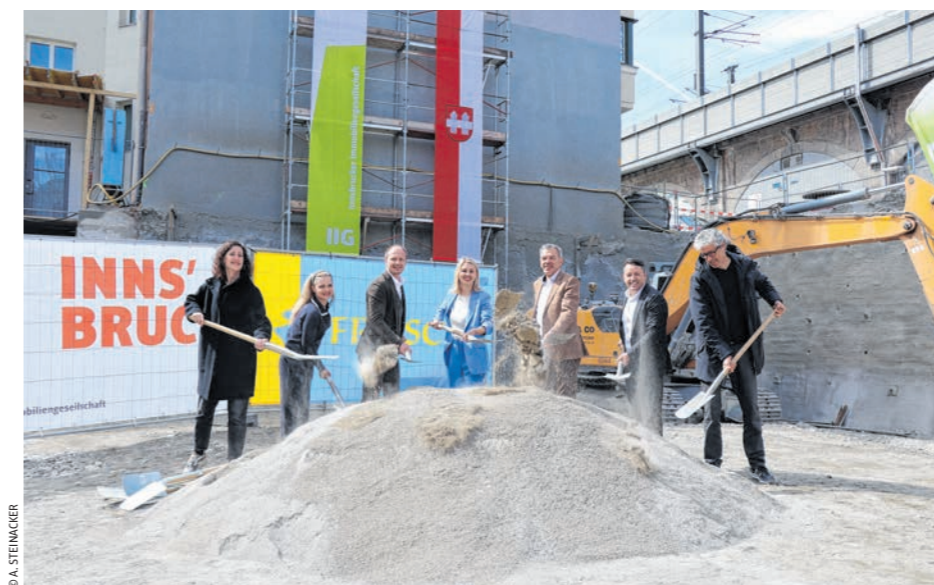
Neubau, Sanierung und Erweiterung: Die Innsbrucker Immobiliengesellschaft (IIG) realisiert im Saggen 292 Wohneinheiten für alle Generationen. Beim Spatenstich am 25. März (v.l.): Arch. Eva López, Aufsichtsratsvors. Anna Girardi, Bgm. Johannes Anzengruber, Vizebgm. Elisabeth Mayr, Vizebgm. Georg Willi, IIG-GF Franz Danler und Arch. Markus Malin. Mehr unter www.innsbruck.gv.at/presse/schlachthofblock-spatenstich
