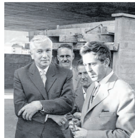
Abb. 2: Bürgermeister & béton brut. In der Mitte Bürgermeister Alois Lugger im Gespräch mit Architekt Norbert Heltschl (re.) anlässlich der Gleichfeier am 3. Juli 1959 im Freibad Tivoli. Im Hintergrund ist jede Menge béton brut sichtbar.
