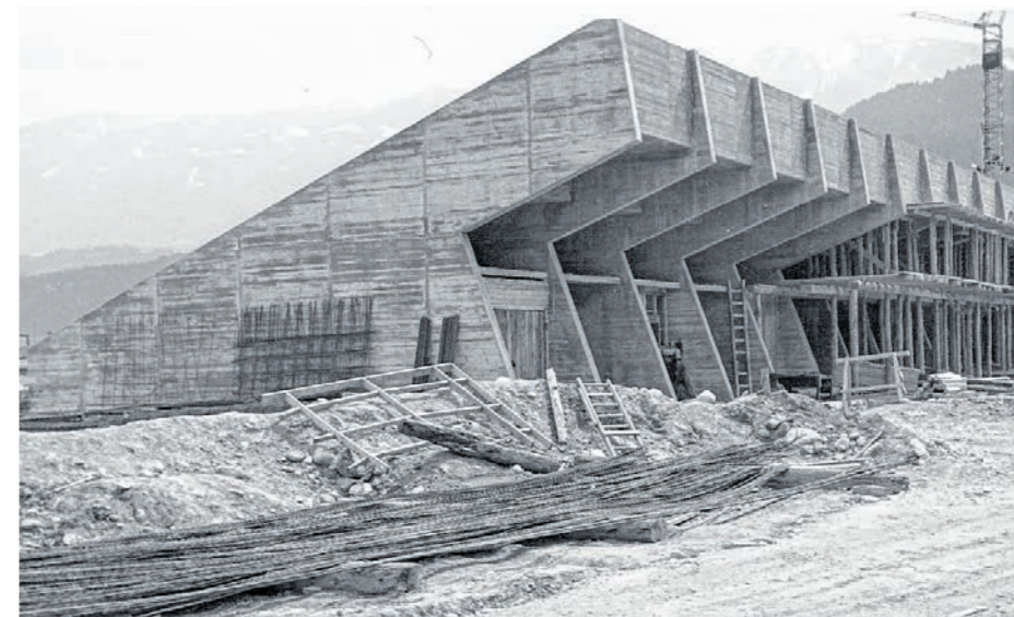
Abb. 3: Rhythmus der Dreiecke. Das Foto zeigt die im Bau befindliche Tribüne für 2.000 Zuschauer, darunter 26 Garagen. Der Bauteil lebt von (rhythmisch gereihten) Dreiecksformen, aus denen Norbert Heltschl auch den Sprungturm aufbaute
