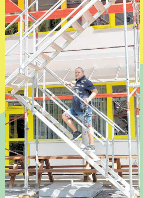
Die Volksschule Hötting West ist während der Sommerferien eine Baustelle.
