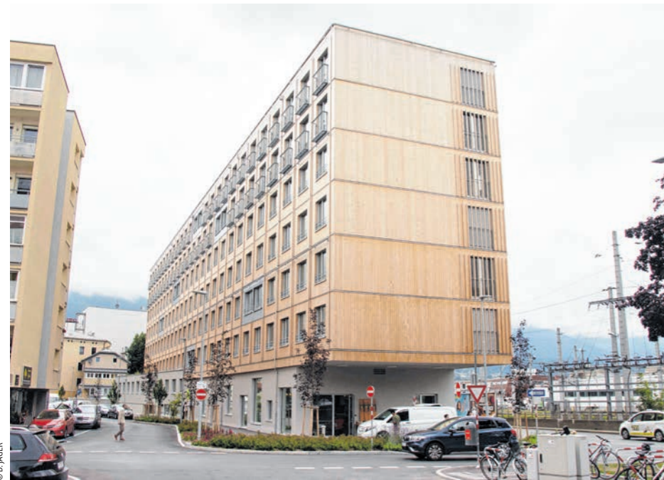
Das neue OeAD-Gebäude in Wilten besticht durch die ökologische Holz-Beton-Hybridbauweise.
